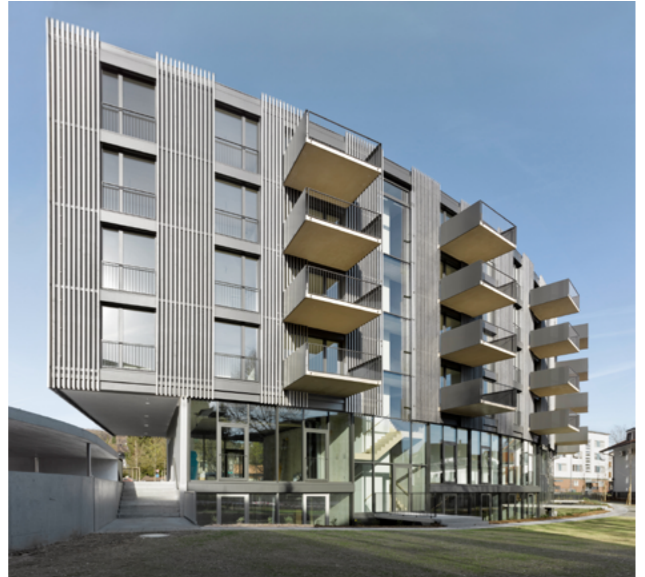
Wohn- und Geschäftshaus Am Neuhauptplatz in Köniz, hintere Fassade © Architekturfotografie Gempeler
